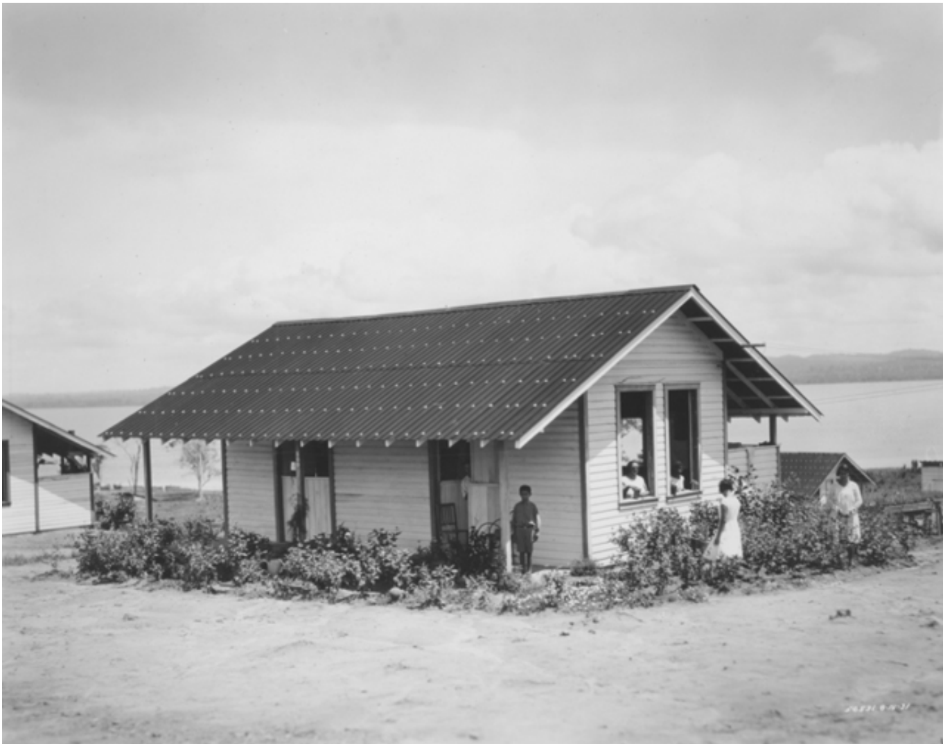
fordlandia, brasilien, arbeiterhaus (foto ca. 1931)
